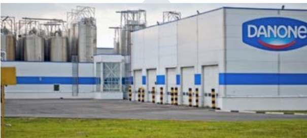
La nueva planta de Danone en Cujik (Holanda)
